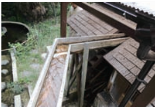
樋から水を引く水車
