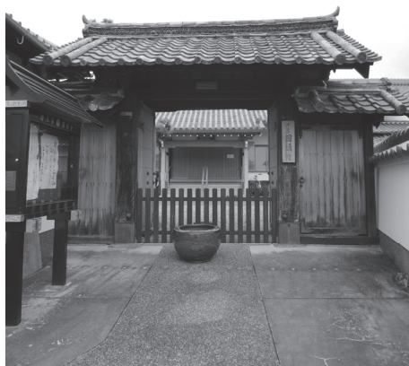
図5 枚方市津田元町2丁目の圓通寺に移築された長尾陣屋の旧陣屋門
