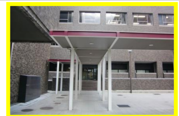
6号館 (1階入口付近)
